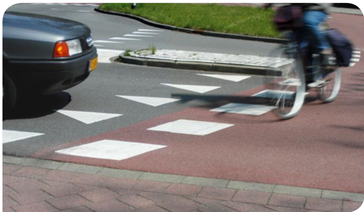
Fietsoversteekplaats met blokstrepen: de haaiantanden regelen de voorrang.
