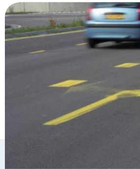
Taludstrepen bij verkeersdrempels geven een hoogteverschil aan.
