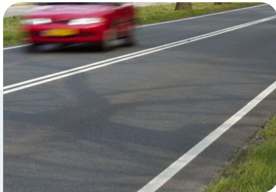
Dubbele doorgetrokken asstreek: niet inhalen.
